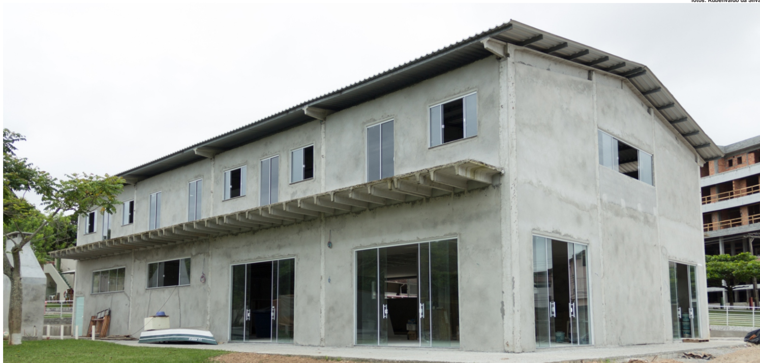
Falta pouco para a Afalesc concluir as obras da nova Sede Praiana nos Ingleses. Um novo espaço para os associados e campistas
